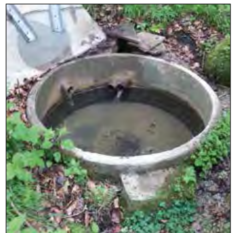
Exemple de l'état actuel des bacs de décantation
